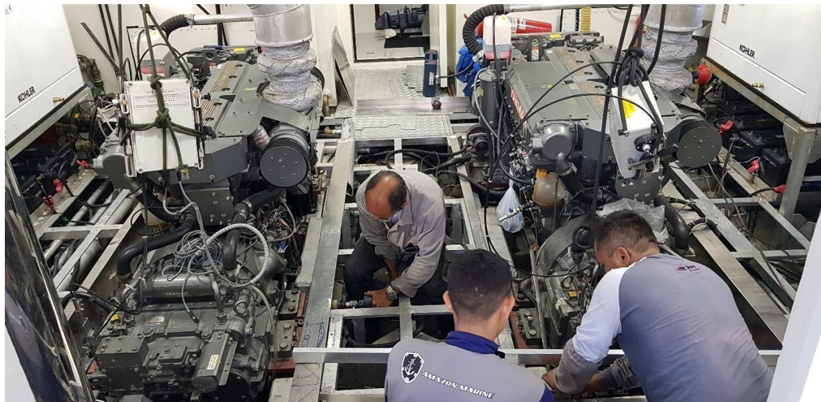
Figura 5. Vista de frente dos motores instalados na embarcação. Alguns operadores realizam serviço de montagem da base das cabines.
