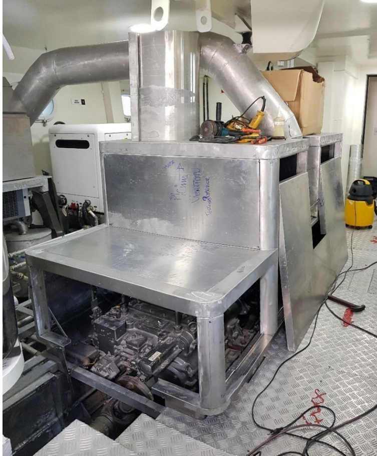
Figura 9. Parede das cabines sendo colocadas. Elas isolam os motores por todos os lados.
